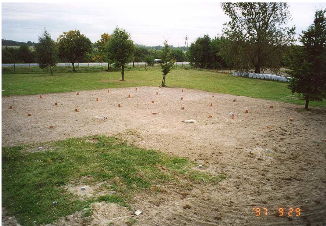
Zdjęcie 2 Widok powierzchni akumulatora po zakończeniu prac ziemnych
